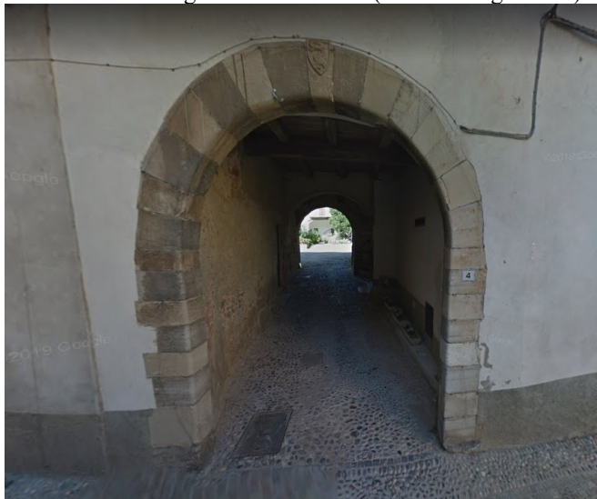
Foto 24 - Portone ingresso Villa Carcano (circuito Google Street)
