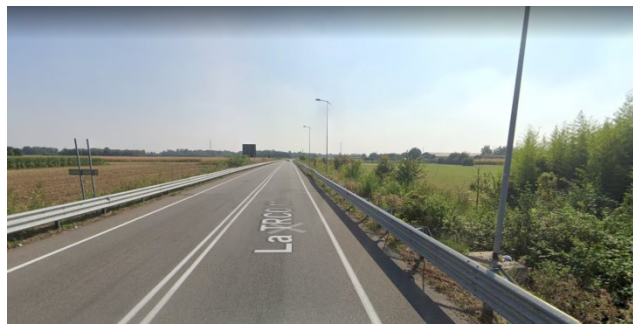
SP 31 Bis – Innesto con SP 32 direzione sud
