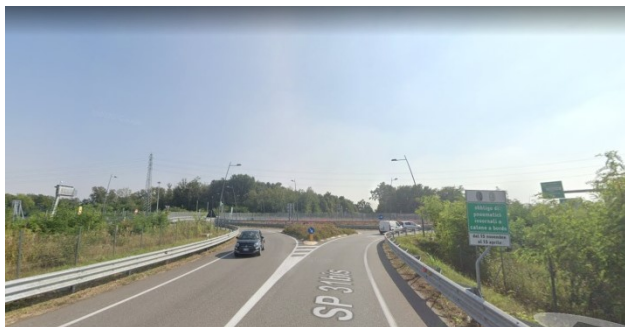
SP 31 Bis – innesto Pedemontana direzione sud
